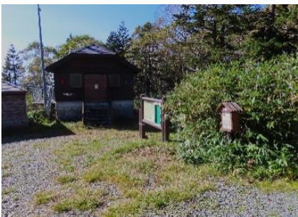
富士見小屋跡。トイレは故障で閉鎖されていた。そして、富士見小屋は取り壊されていた。
